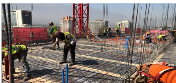
Obra gruesa piso 14
